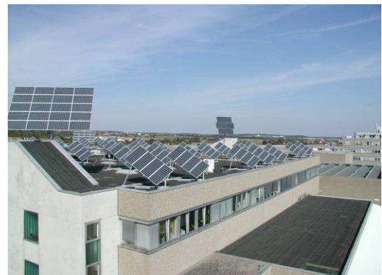
Einachsige- und zweiachsige- nach geführte Photovoltaikanlagen auf der Halle 4
